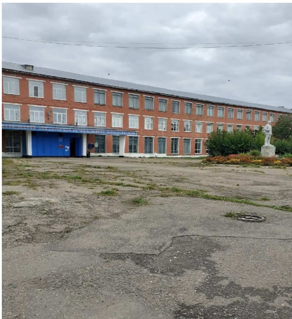
Фото 1- Территория, прилегающая к зданию
