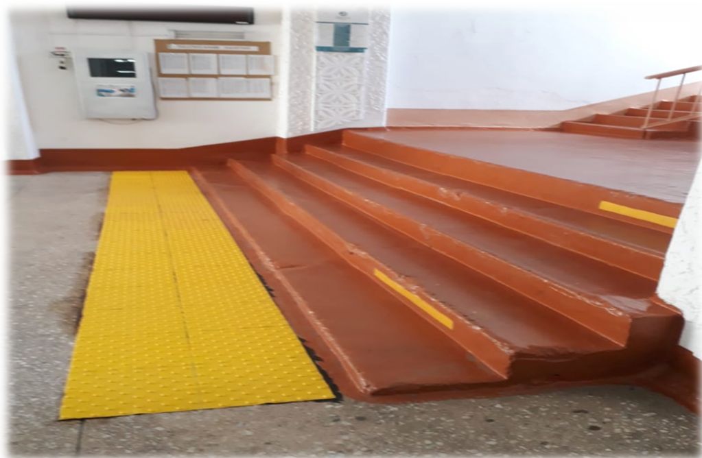
Фото 15- Лестница внутри здания
